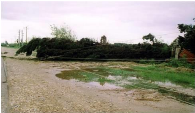
شکل ۳: سقوط درخت بر روی شبکه فشار متوسط در طوفان تابستان ۹۵
