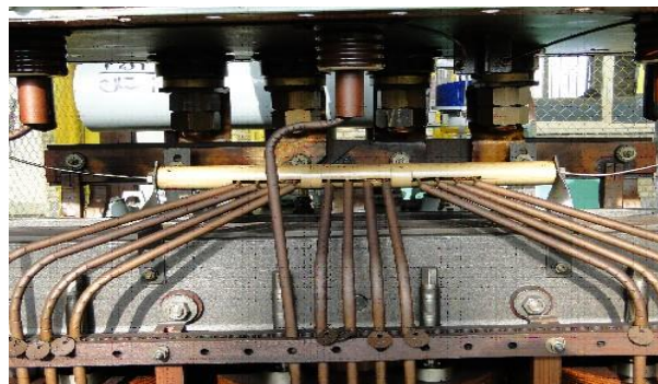
شکل (۳): اتصال میله فاز به بدنه
